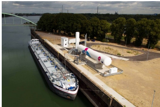
Desde terminales de GNL
